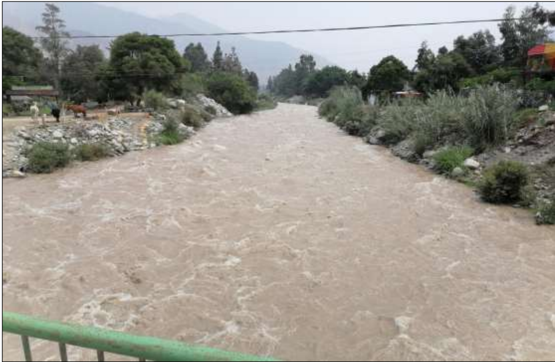
Fotografía 1.- Fotografía desde el Puente Ranchito, en dirección aguas arriba.
